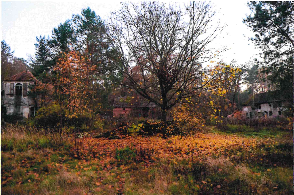
Abbildung 1: Blick auf die Alte Försterei, Bild: G. Sachs
