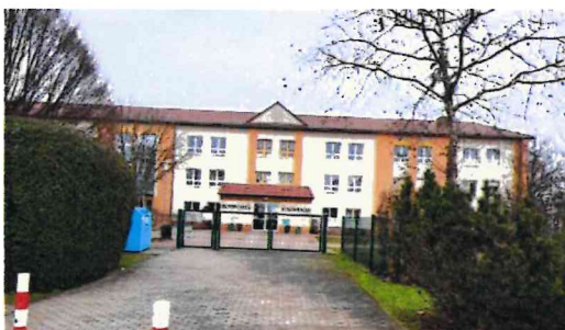
Im Nordosten angrenzendes Schulgebäude
