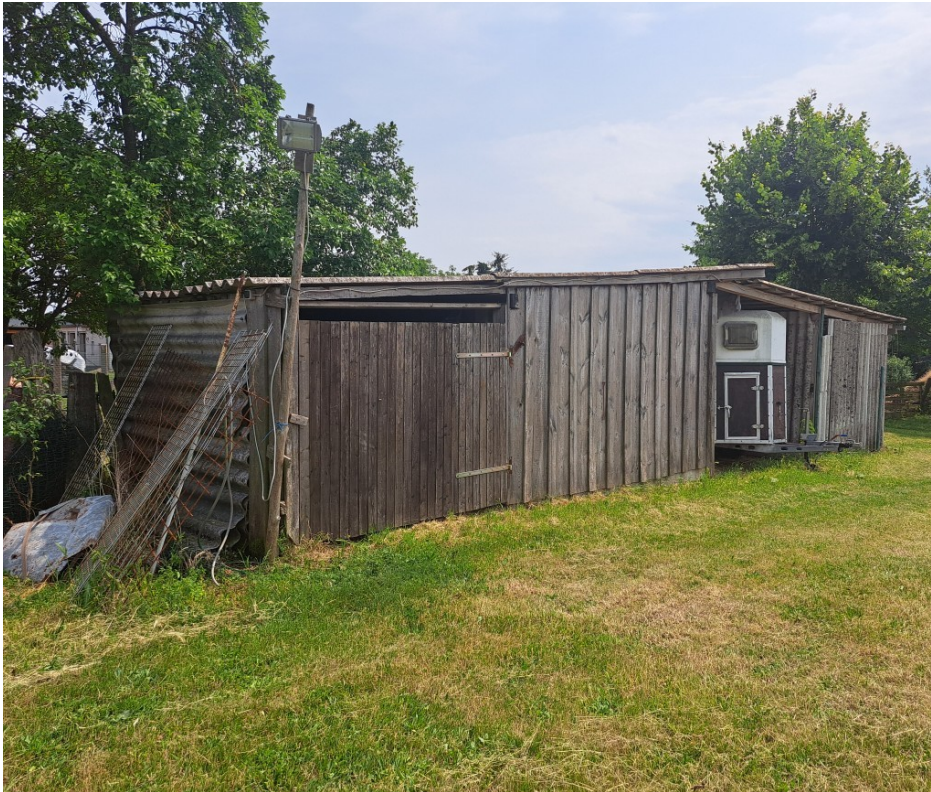
Schuppen an östlicher Grundstücksgrenze (bei Abriss Artenschutzgutachten notwendig)
